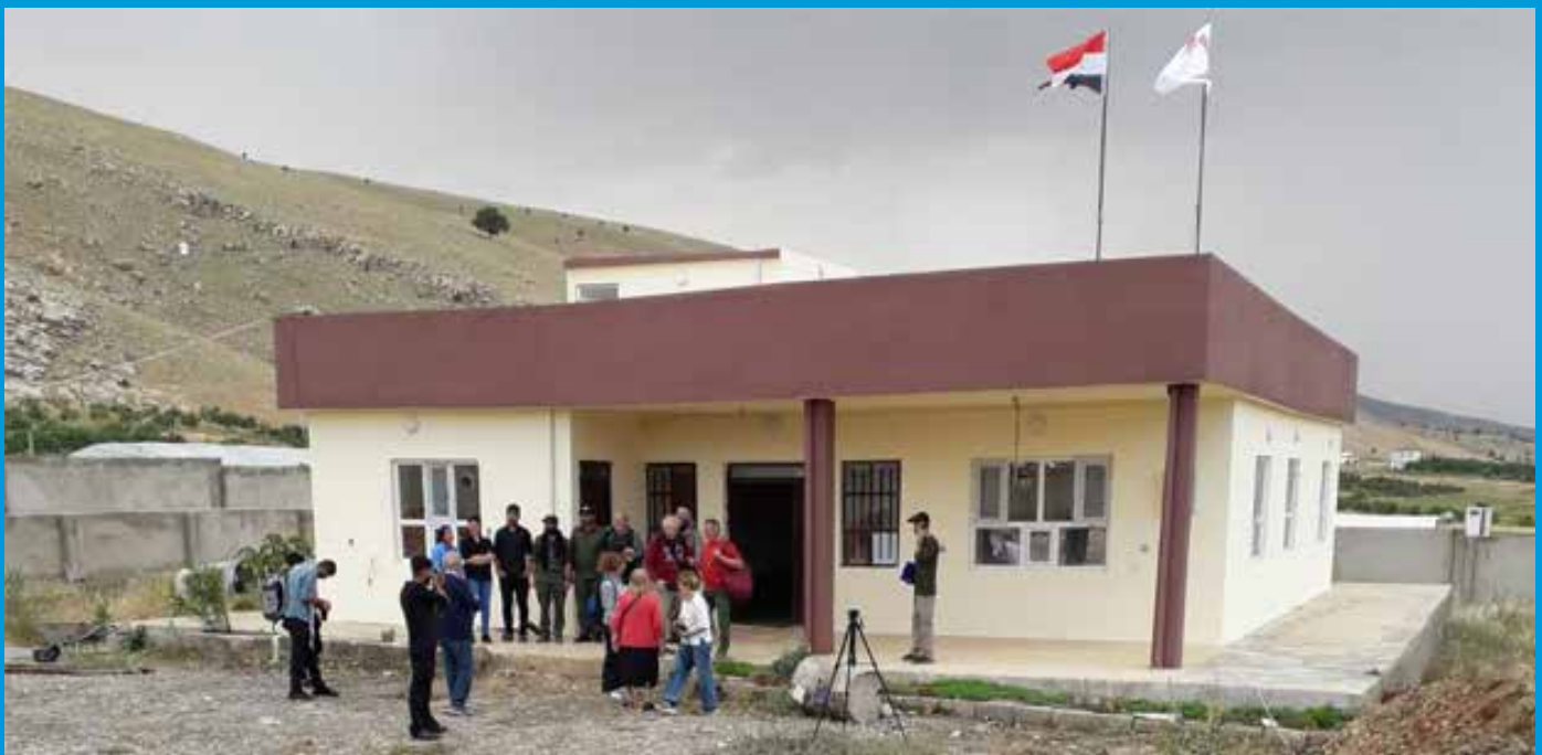
IL CENTRO SANITARIO CHE ABBIAMO REALIZZATO A SERDEST
